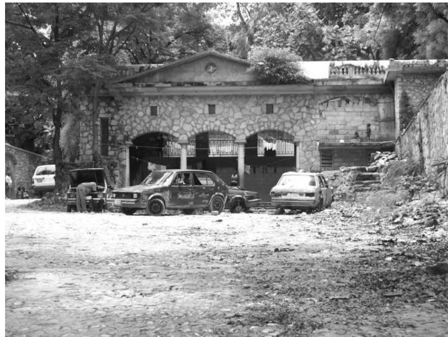
Entrée de l'ancien hôtel de l'habitation Leclerc, aujourd'hui squatté, Port-au-Prince, 2007
